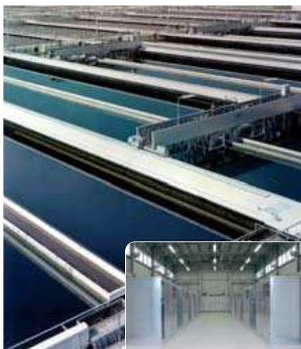
•Napowietrzanie ścieków przy użyciu agregatu Robox evolution.
